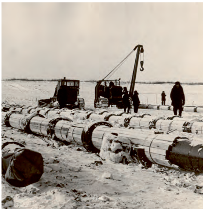
Строительство газопровода Мессояха – Норильск, 1969 г.
