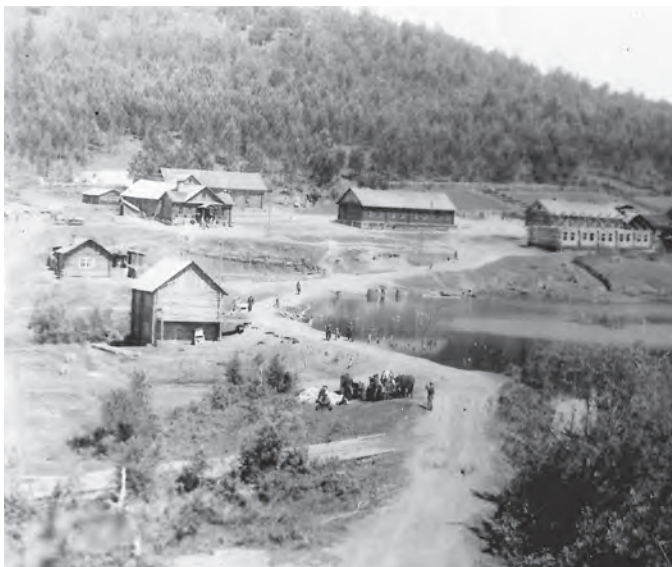
Электростанция на запруде в деревне Бычковке Ирбейского района
