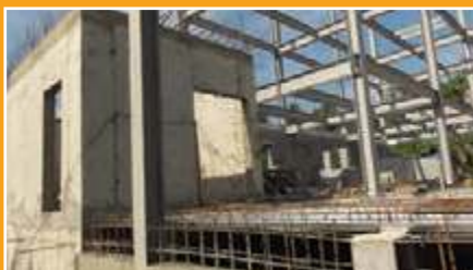
К старой фасадной стене, сохраненной ради исторической мозаики, присоединили новые отстроенные из газобетонных блоков стены
