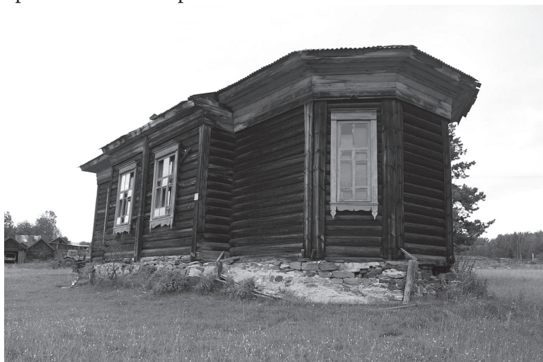
Рис. 6. Церковь Казанской иконы Божией Матери в деревне Минск — современное состояние здания церкви. Фото из открытых источников [16]
