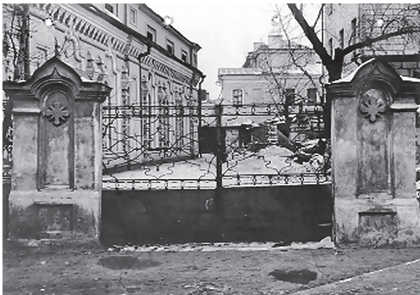
Рис. 12. ГАКК Ф. 2548. Оп. 3. Д. 1. Проект ремонтно-реставрационных работ на Покровской церкви по ул. Сурикова, 26, в г. Красноярске. Исходно-разрешительная документация. Рабочие чертежи ограды (текст, чертежи, рисунки). Инженер Э. Ф. Новак. 1859–1968 гг. Л. 23
